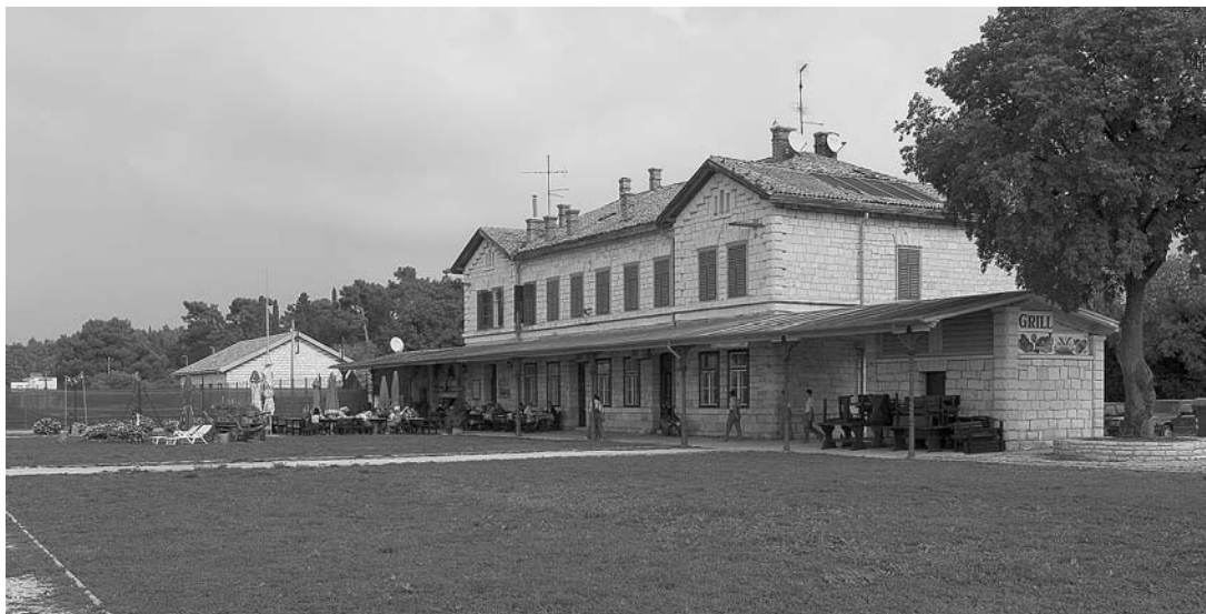
sl.3. Željeznička stanica Rovinj, 2006. Nakon modernizacije ceste Kanfanar – Rovinj još se više razvio cestovni promet pa je odlučeno da se promet tom prugom obustavi. Prugom Kanfanar – Rovinj posljednji je vlak prošao 20. listopada 1966.
