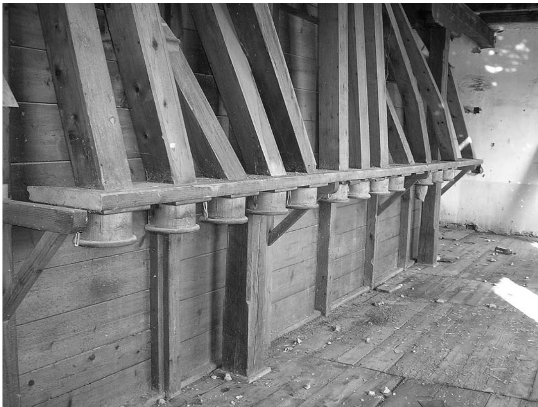
sl. 8.-12. Ostaci opreme interijera u prizemlju, na katu i u potkrovlju Hubenyyeva mlina Fotodokumentacija: Vida Pust Škrkulja, rujan 2007.
