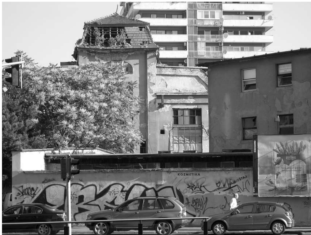
sl. 4.- 5. Kompleks bivše tvornice "Badel", na križanju Martičeve i Šubićeve ulice u Zagrebu danas je prepušten polaganom propadanju, dok istodobno u njegovom sklopu niču nove dogradnje, 2008. Snimila: L.D.T.
