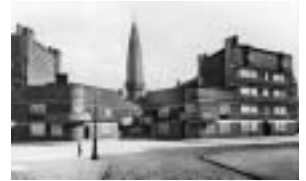
sl.2 Monumentalni stambeni blok arhitekta Michela de Klerka, Spaarndammer trg, Amsterdam
