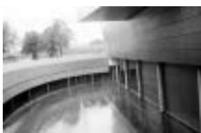
sl.3 Nova zgrada. Polukružni bazen s vodom.
