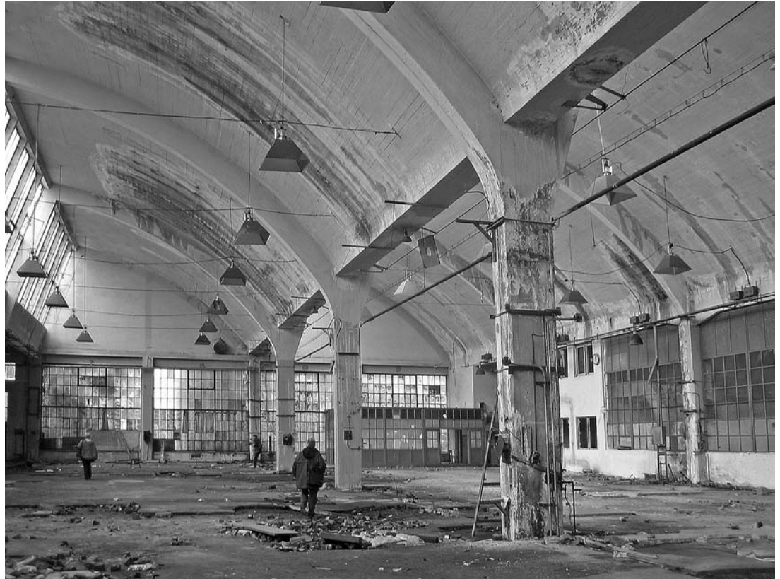
sl. 4. Tvornička hala broj 19 u praškom okrugu Vysočany: predviđena prenamjena u školski objekt
