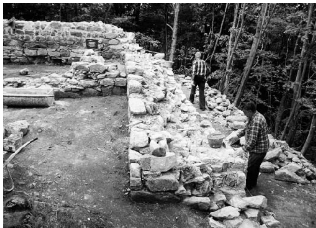
Konzervacija na terenu: sjeverozapadni obrambeni zid utvrde Paka
