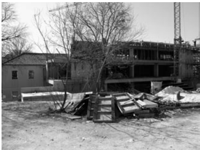
Radovi na adaptaciji zgrade Galerije umjetnina
