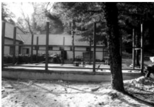
Izgradnja gospodarskog objekta
