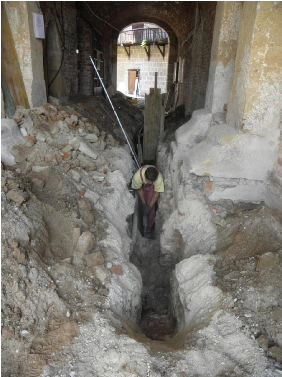
Radovi u veži utvrde Stari grad Đurđevac
