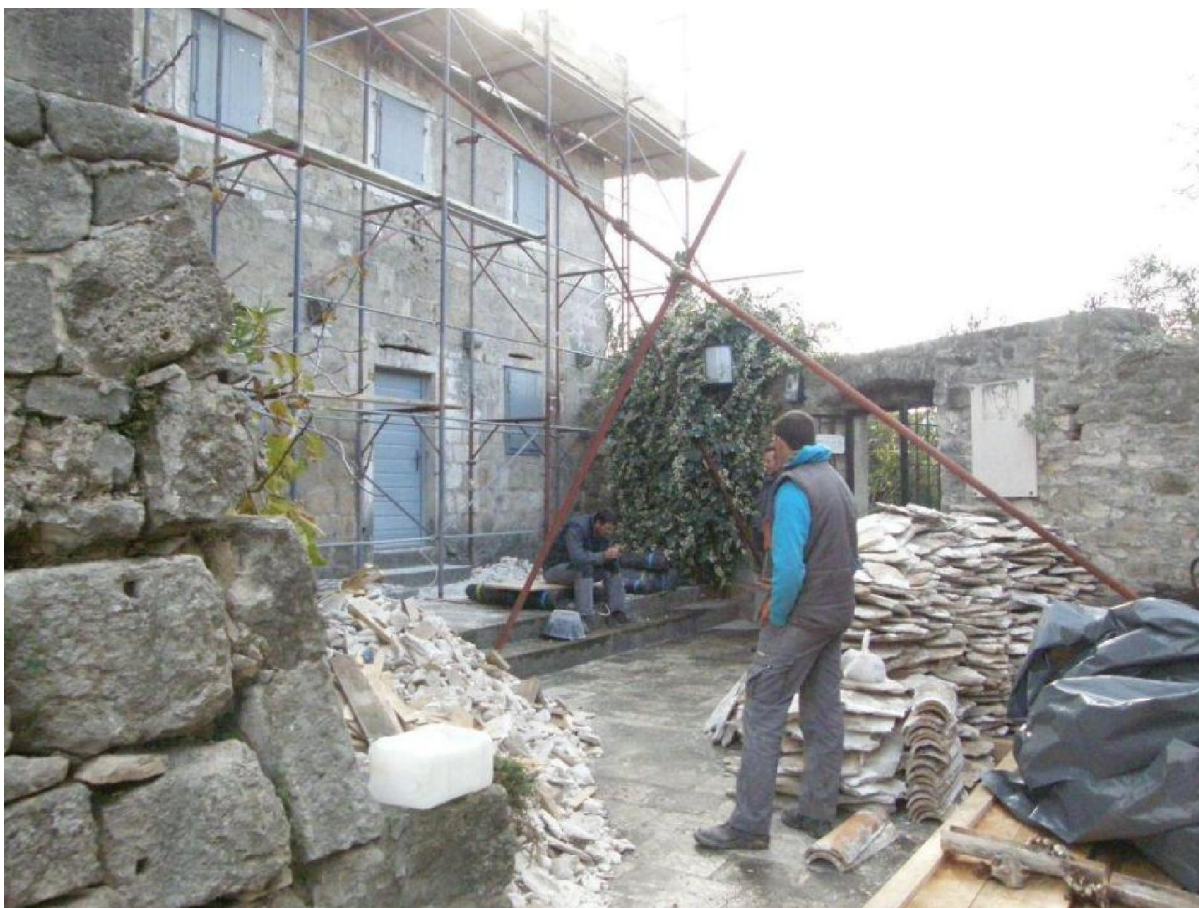
Zaštita - Radovi na popravku oštećenog krovišta
