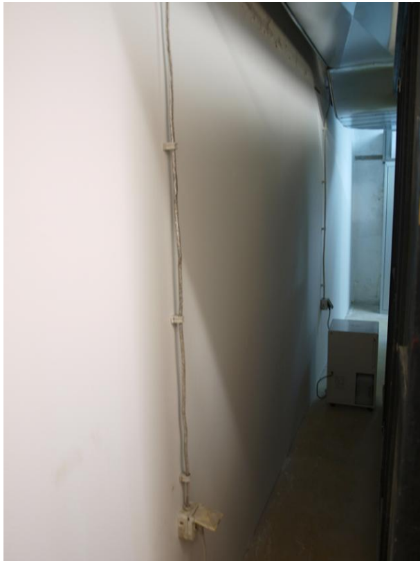
Slika 17. Izvršena sancija zida u čuvaonici
