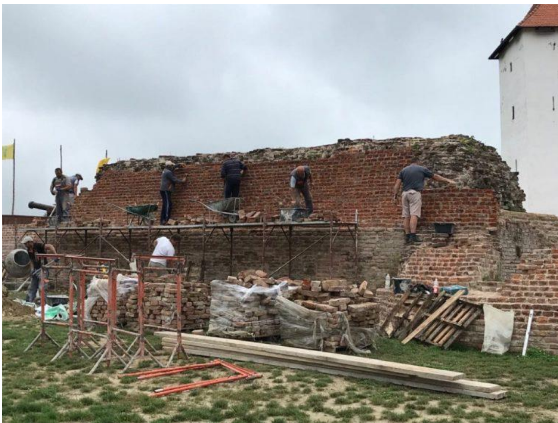
Slika 2. Zaštita kulturnog dobra Stari grad Đurđevac – Radovi konzervacije i konsolidacije bedema
