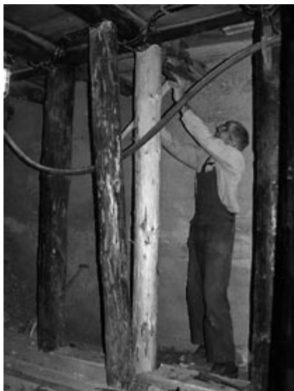
Tehnički muzej, obnova podgrađa u rudniku
