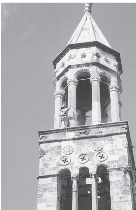
Radovi na zvoniku Sv. Marka
