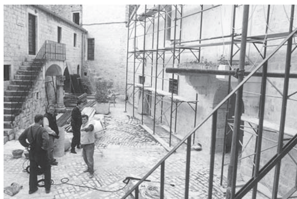
Sanacija dijela palače Garagnin Fanfogna
