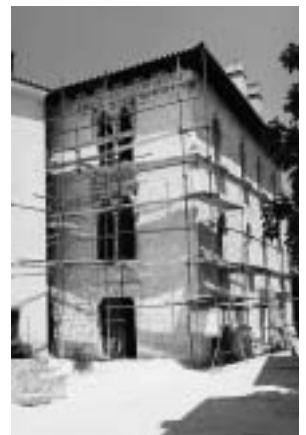
sl.1 Završni radovi na palači Arsan u Cresu (foto N. Mavrović)
