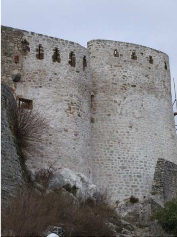
Građevinska i konstruktivna sanacija zidova kninske tvrđave
