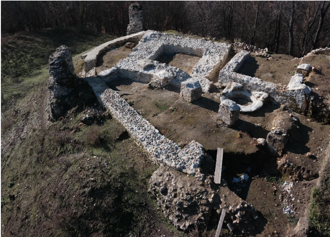
Sl. 1. Konzervacija zida kvadratične branič kule i cisterne te dijela palasa i vanjske zidine, 2015.
