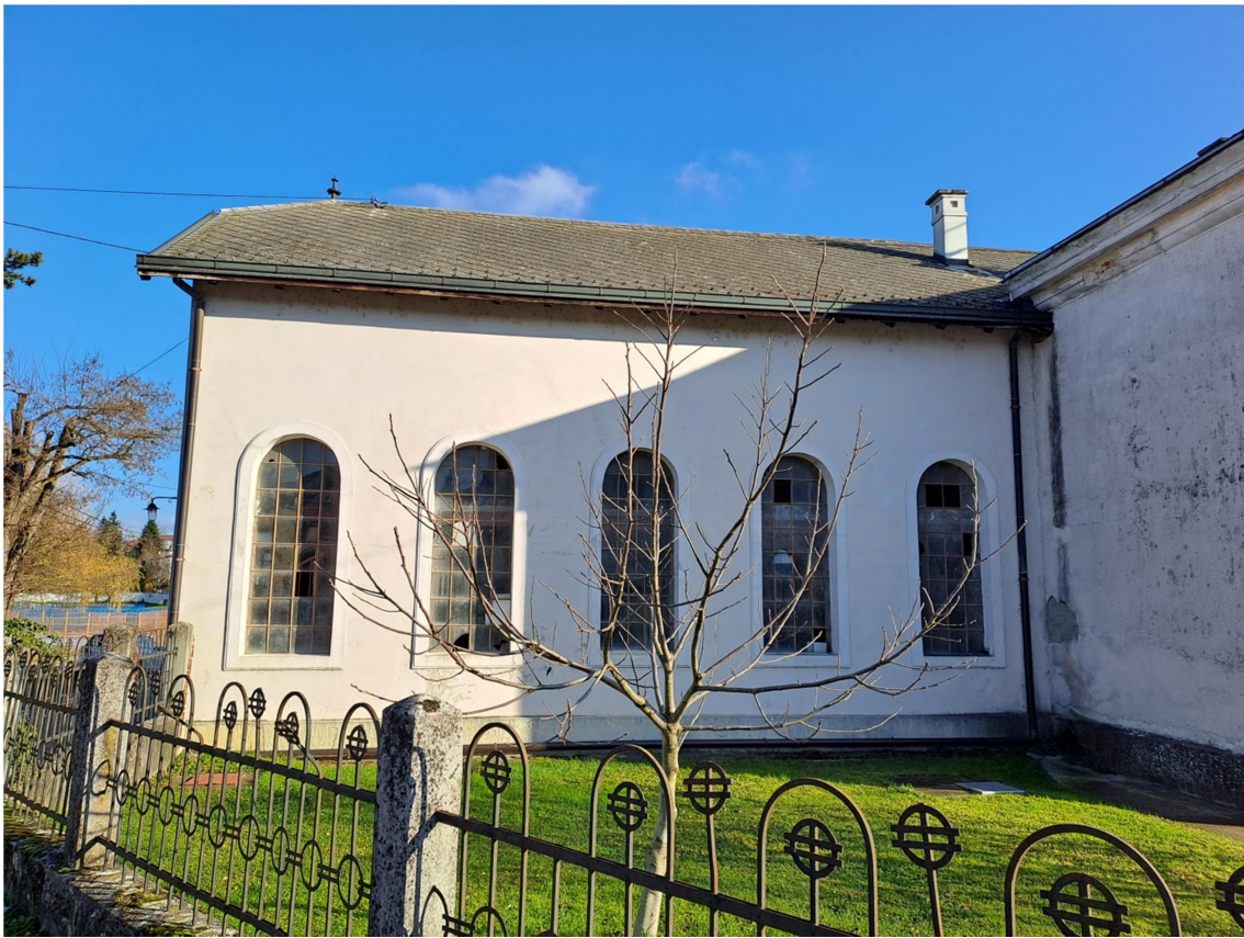
Foto 11. Zgrada križevačke Munjare u kojoj je smješten generator Ganz
