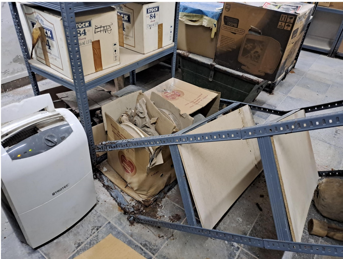
Foto 7. Nužno je hitno sanirati problem s vlagom budući da korozija uništava police i predmete
