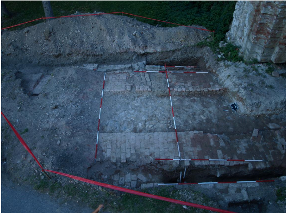
Snimak građevnih ostataka mosta (Sjeverna Kurtina u Staroj Gradiški)
