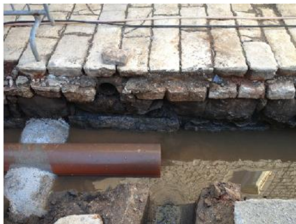
Sl. 2 Uočeni veći kameni blokovi u starom kanalu za kanalizaciju na predjelu Ploča
