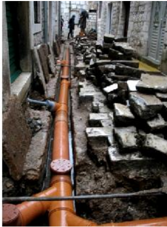
Sl. 1 Iskop za kanalizaciju u ulici iza apside crkve Sv. Stjepana
