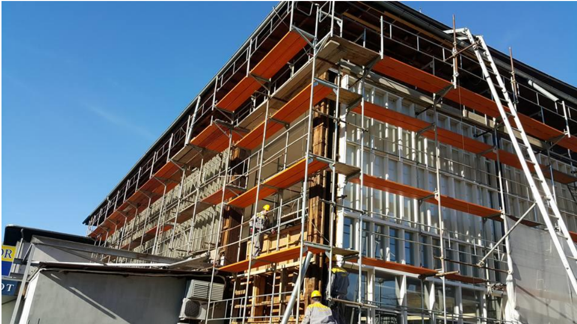
Obnova muzejske zgrade – hala A
