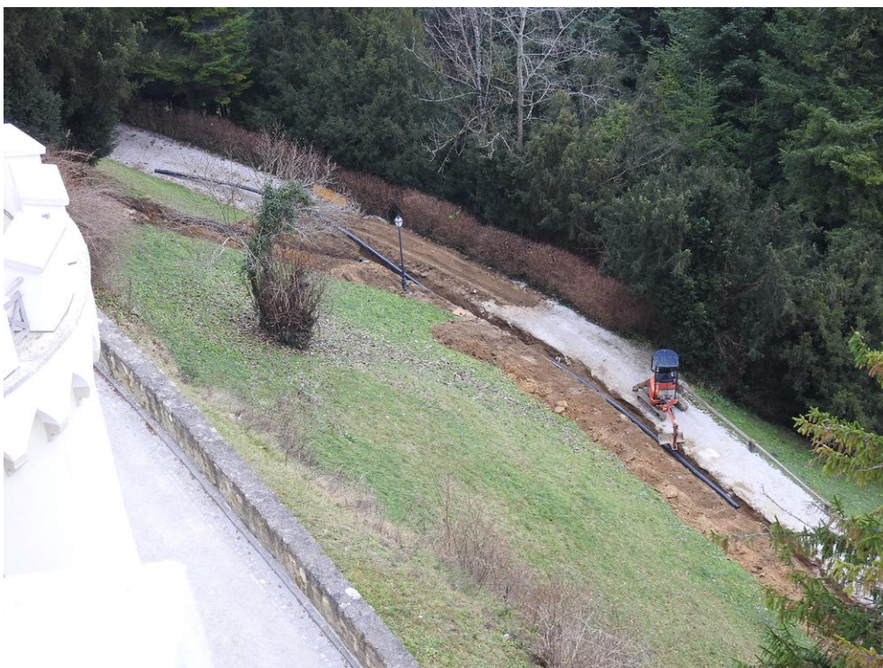
Slika 6. Radovi na izgradnji nove hidrantske mreže, prosinac 2019.
