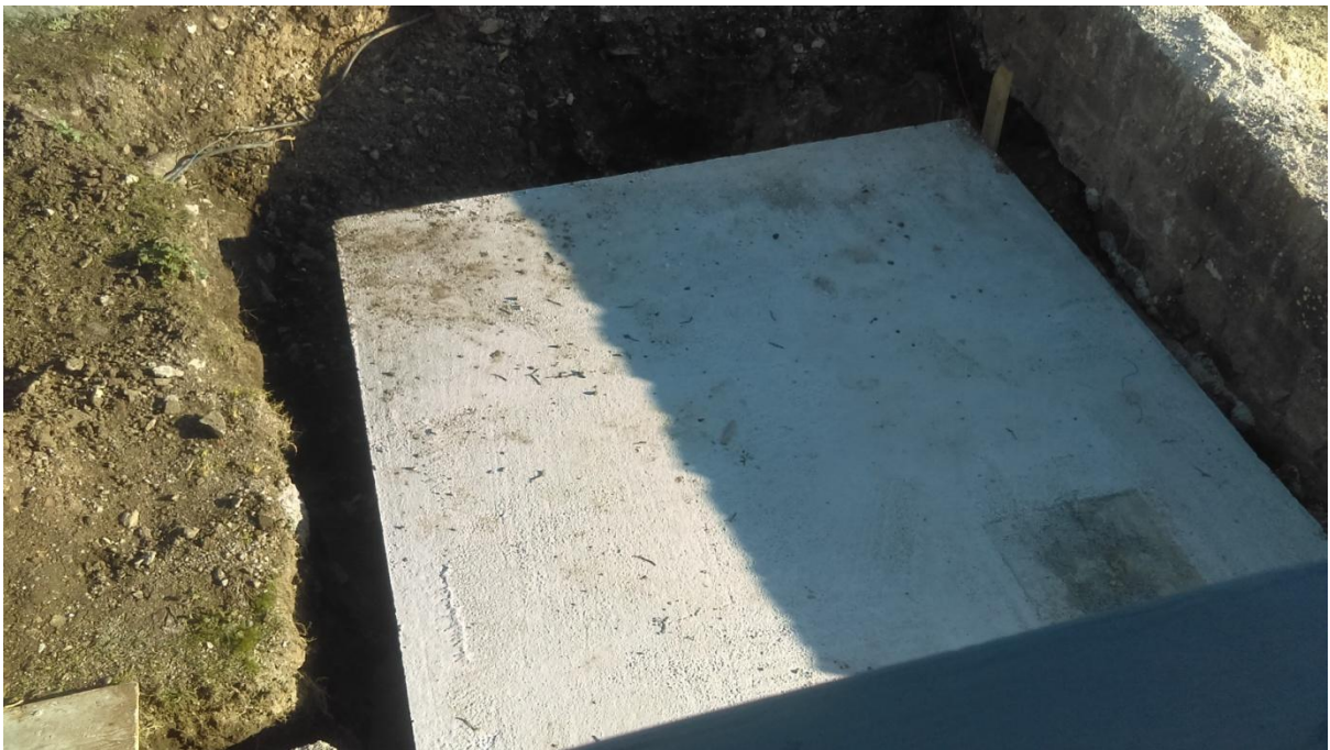
Slika 61. Radovi na uspostavljanju sanitarnog čvora
