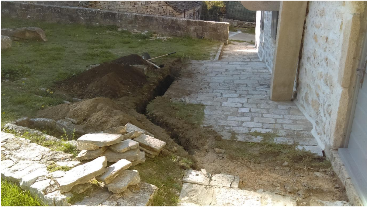
Slika 56. Radovi na uspostavljanju sanitarnog čvora
