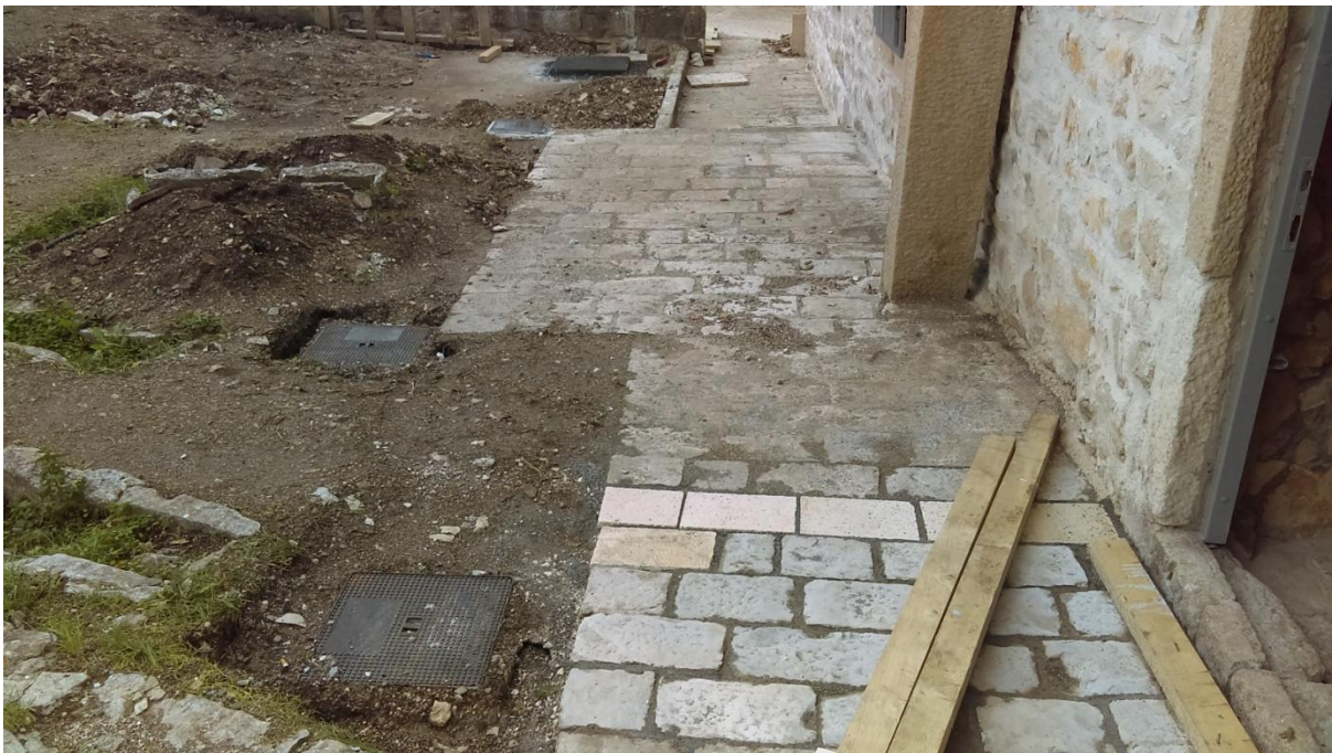
Slika 63. Radovi na uspostavljanju sanitarnog čvora
