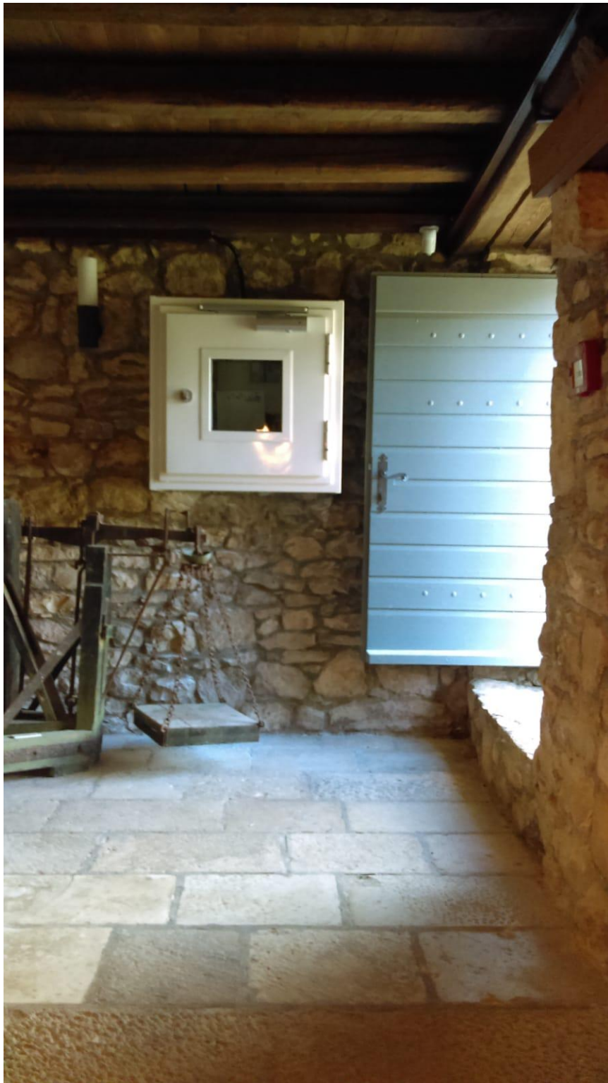
Slika 53. Montaža protupožarnog ormarića
