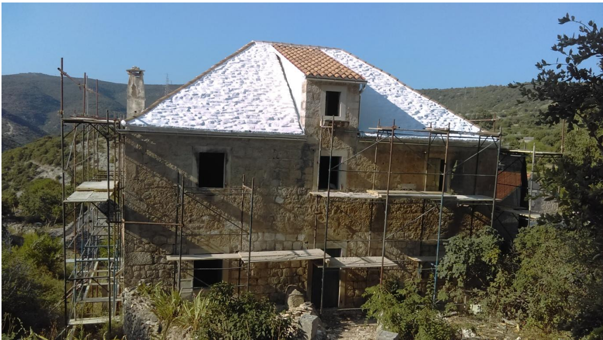
Slika 55. Radovi na Župnoj kući
