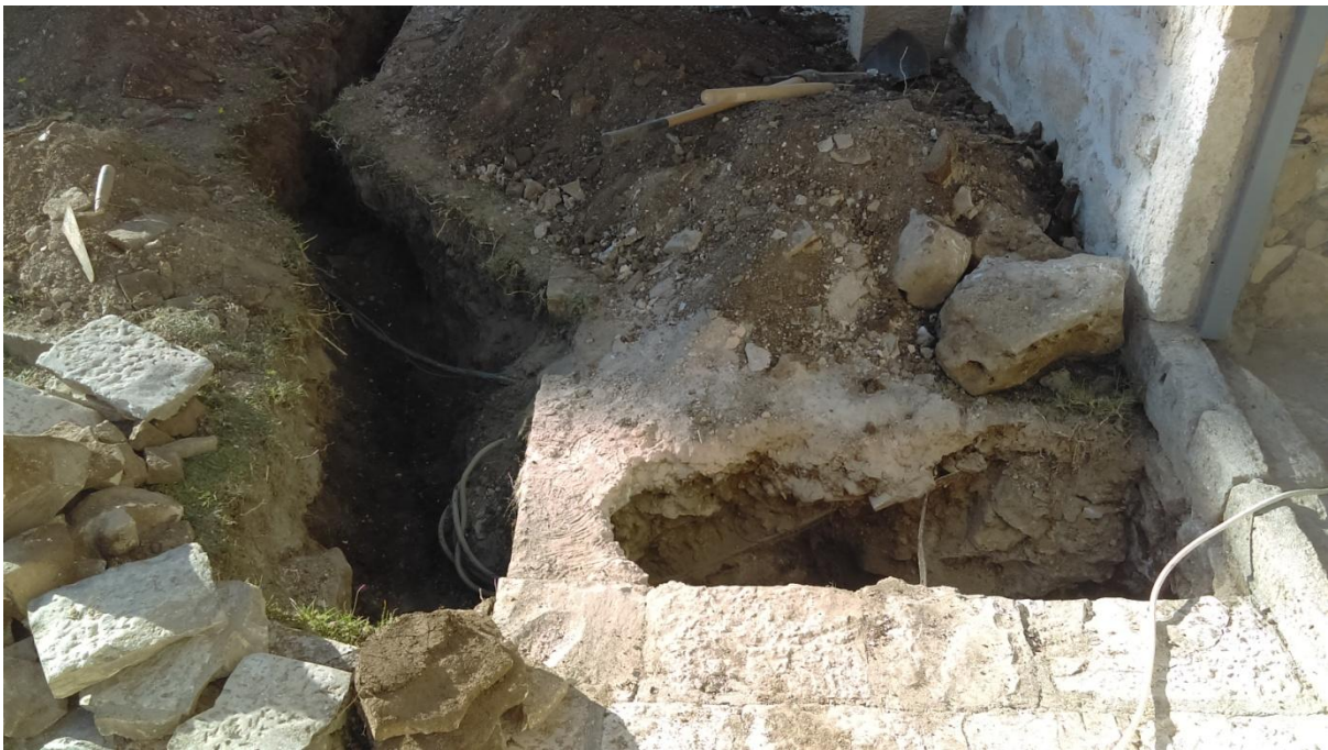
Slika 57. Radovi na uspostavljanju sanitarnog čvora
