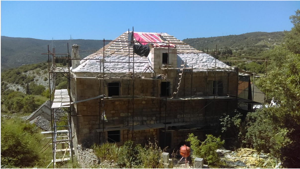
Slika 54. Radovi na Župnoj kući
