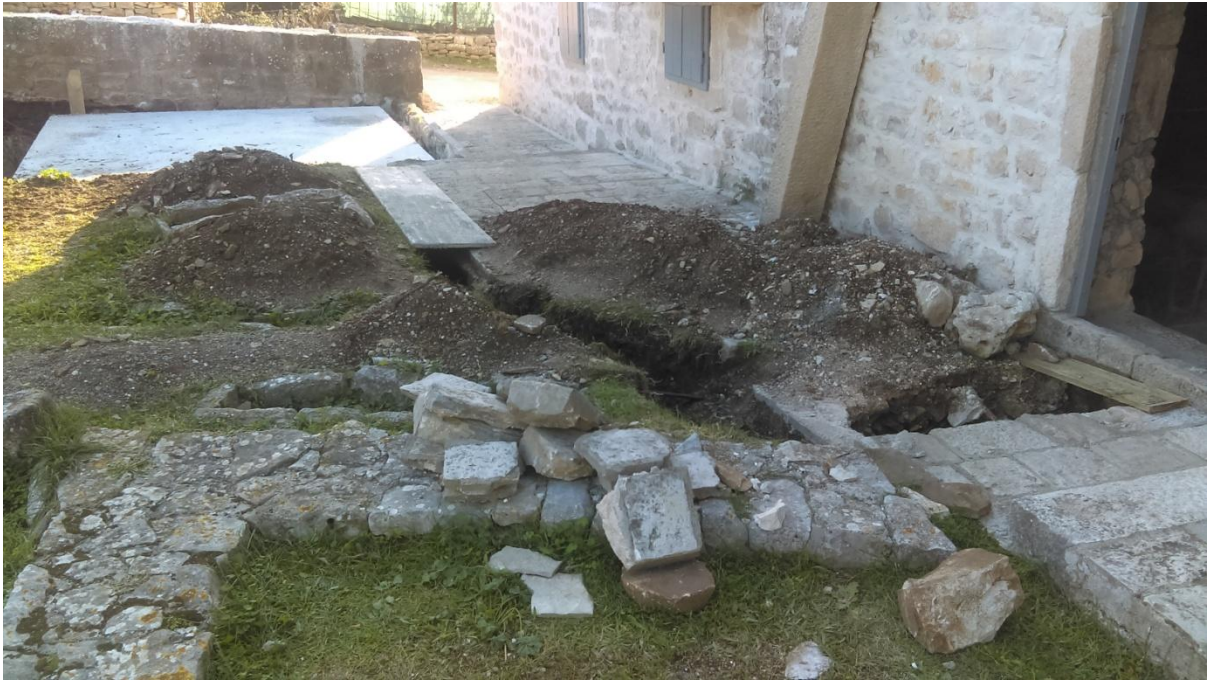
Slika 62. Radovi na uspostavljanju sanitarnog čvora
