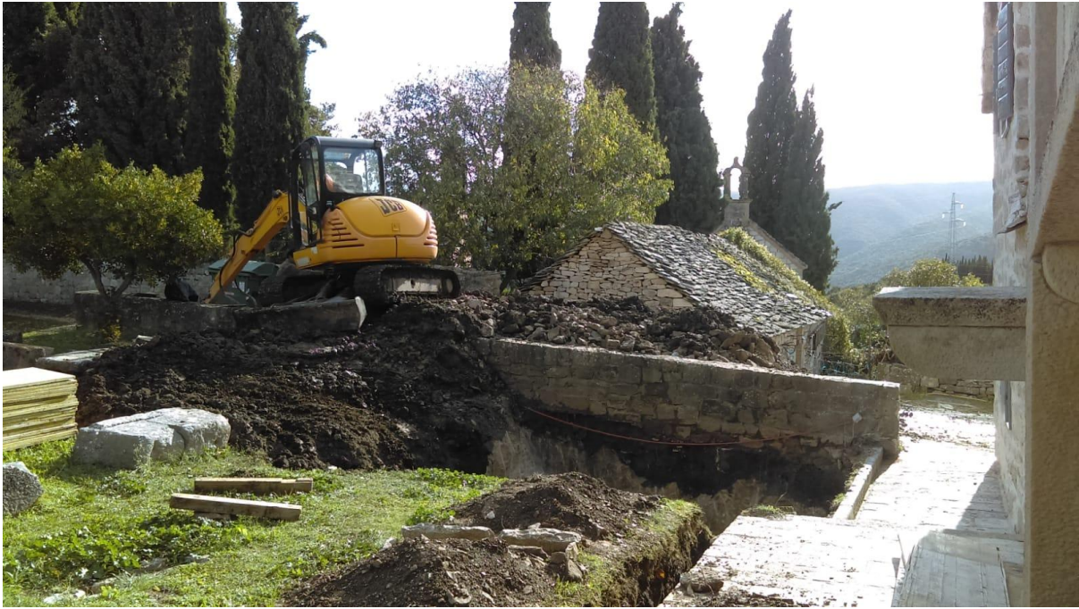
Slika 58. Radovi na uspostavljanju sanitarnog čvora
