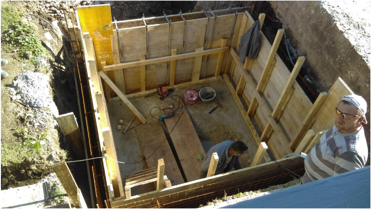
Slika 60. Radovi na uspostavljanju sanitarnog čvora
