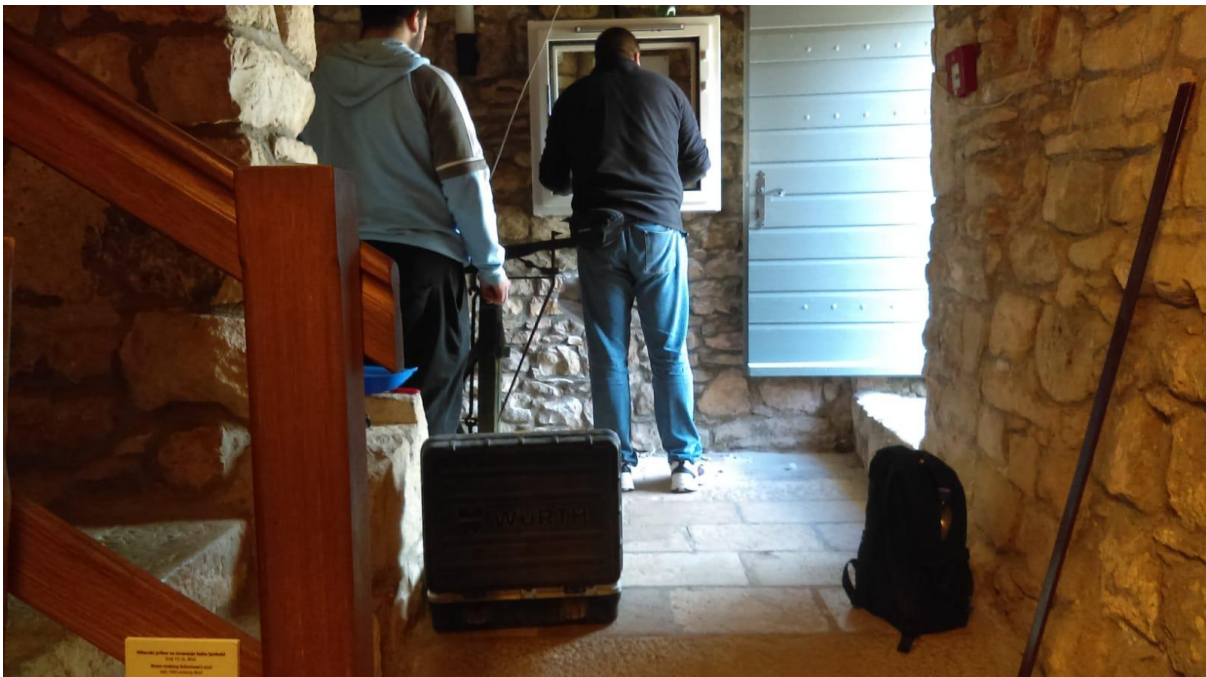
Slika 52. Montaža protupožarnog ormarića
