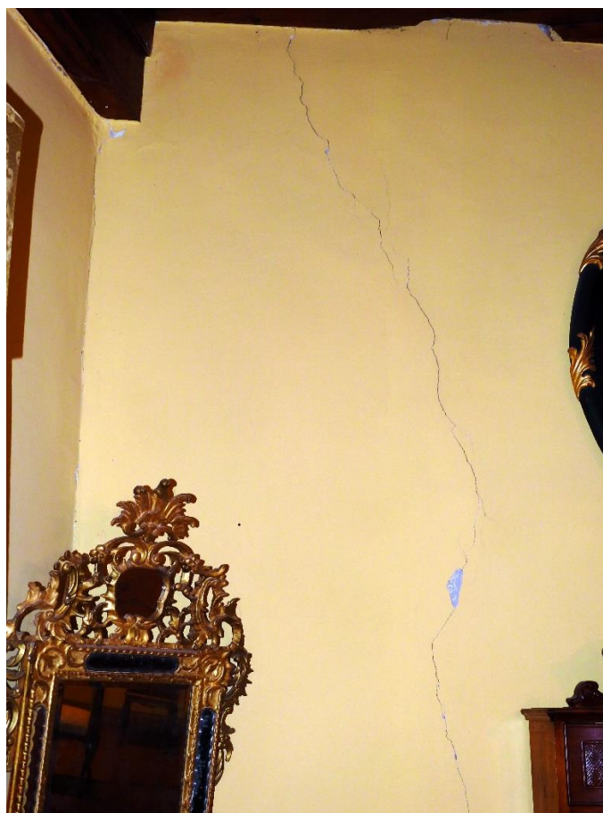
Slika 6. Oštećenje na drugom katu dvorca nastalo nakon dvaju potresa
