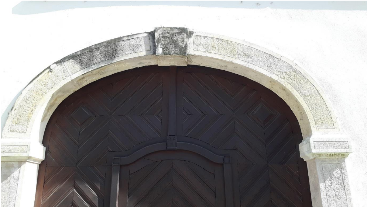
Slika 18. Čišćenje kamenog portala palače Herzer, prikaz očišćene desne strane luka i neočišćene lijeve strane luka (J. Cepanec)
