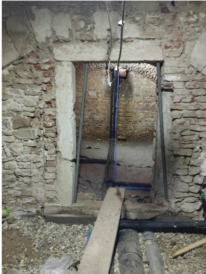
27. Konzervatorsko-restauratorski radovi na kamenom portalu u podrumu varaždinske Gradske vijećnice
