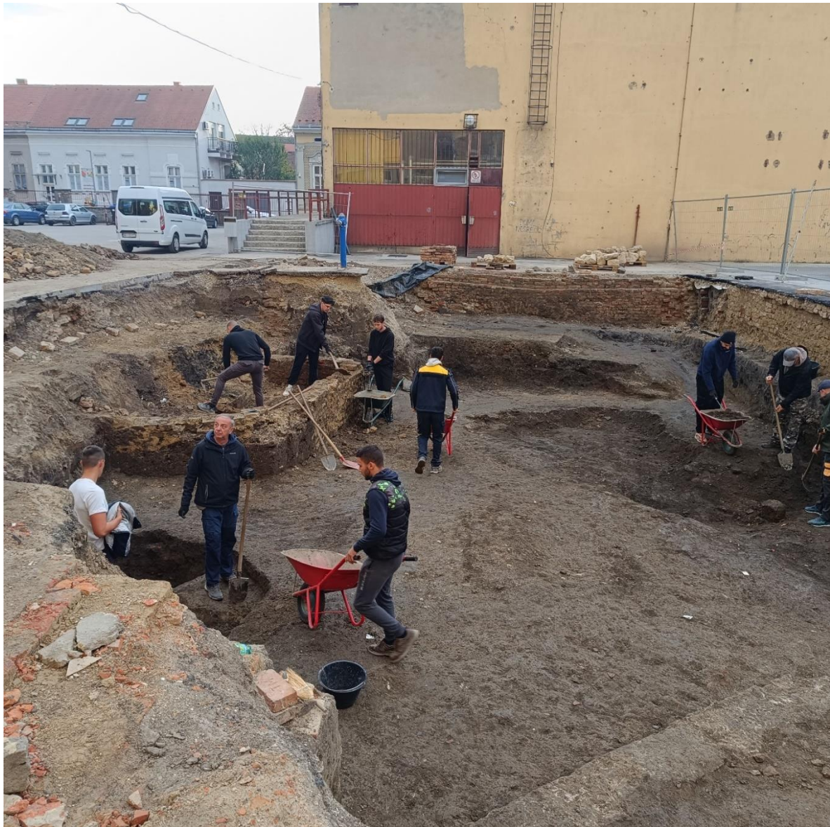
Slika 3. Iskopavanje na Gimnaziji
