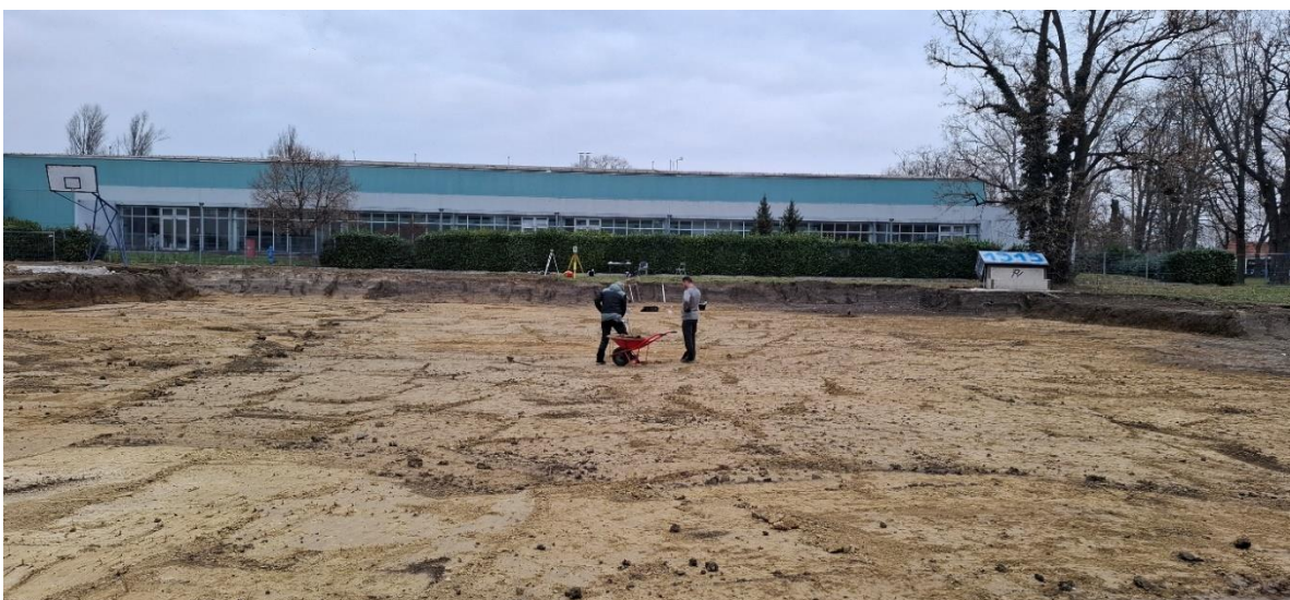
Slika 4. Iskopavanje bazena u Lenijama
