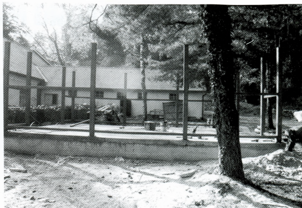
Izgradnja gospodarskog objekta
