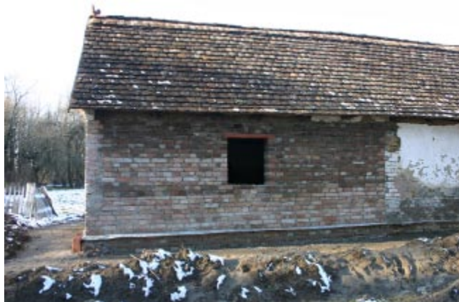
Radovi na sanaciji tradicijskoga objekta koljebe
