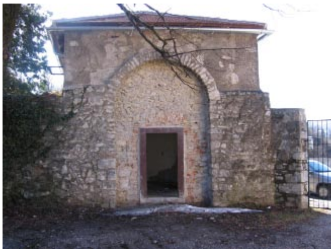
Kapela Bernardina Frankopana nakon sanacije krova i vlage
