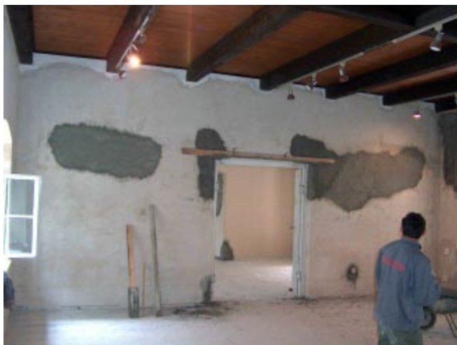
Radovi na prizemnoj zgradi
