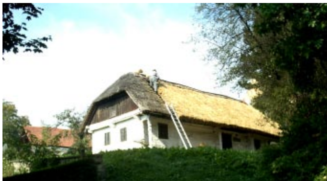
Obnova raženog krova seoske kuće – zagorske hiže
