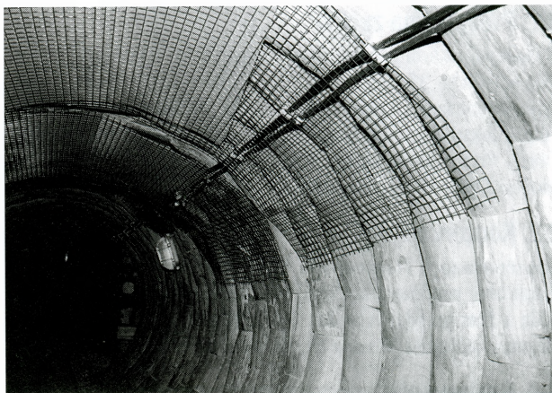
Drvena poligonalna podgrada prije izmjene
