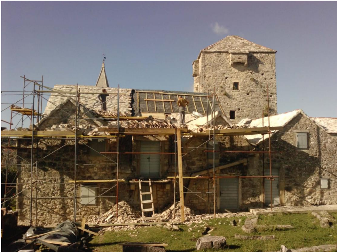
Sl. 34. Radovi na krovu muzeja 1
