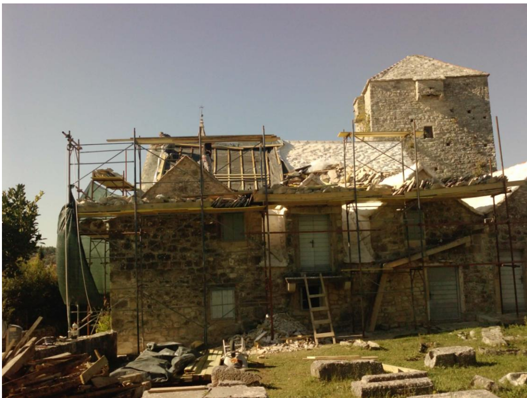
Sl. 35. Radovi na krovu muzeja 2
