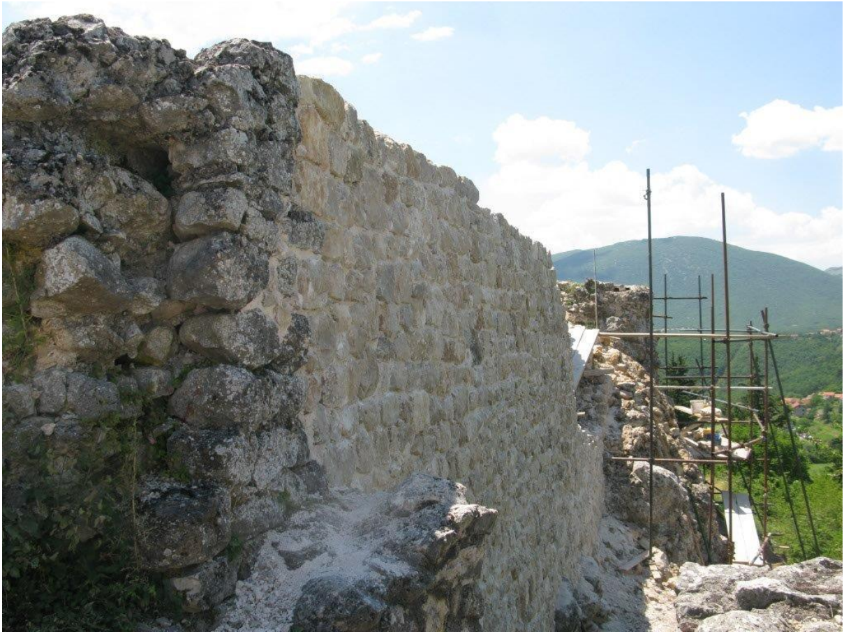
Sl. 22. Sinj - tvrđava Grad, konzervatorsko-sanacijski radovi na sjevernom bedemu
