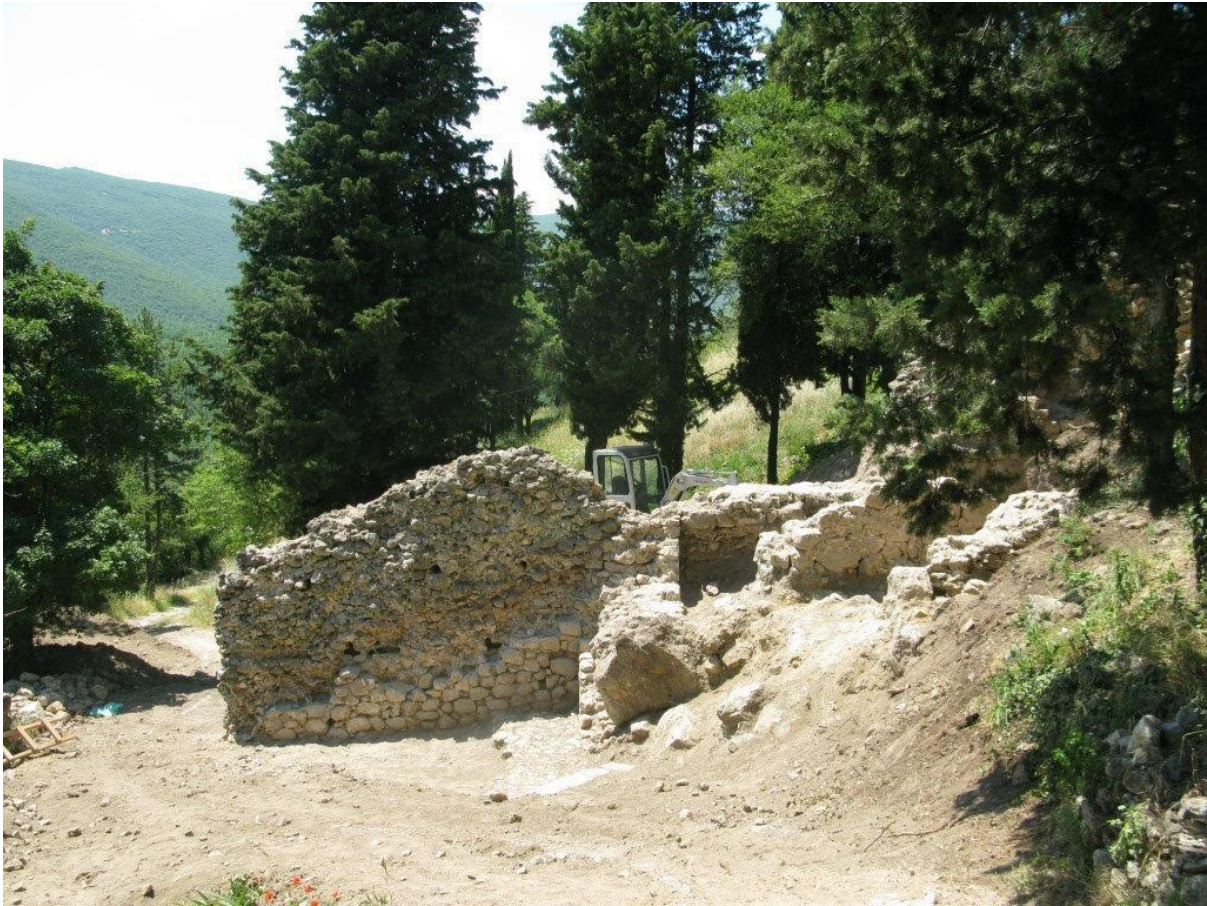
Sl. 24. Sinj - tvrđava Grad, pogled s istoka na unutrašnje lice zapadnog bedema
