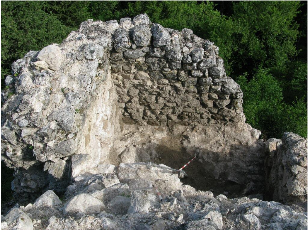
Sl. 23. Sinj - tvrđava Grad, pogled na istraženu površinu - sjeverozapadna kula
