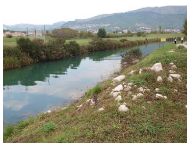
Sl. 5. Rijeka Žrnovnica uzvodno od mosta na Jadranskoj magistrali
